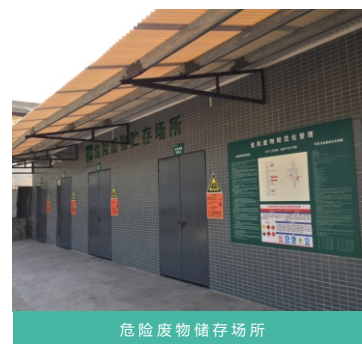
危险废物储存场所
